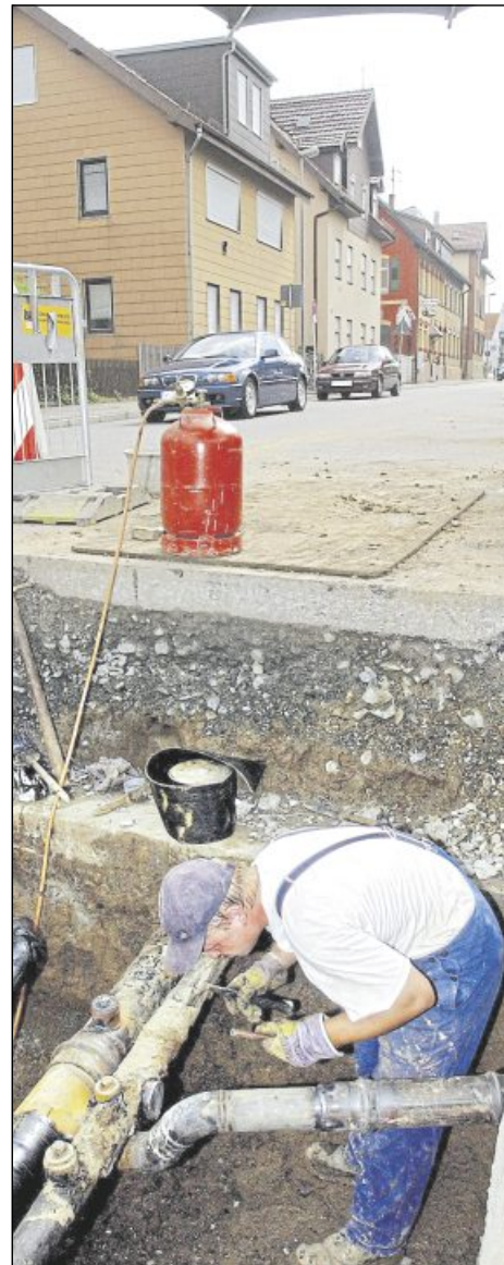
Arbeiten an einer Gasleitung in Rommelshausen im Jahr 2015. Versorgt werden die Kernener von der Netze BW, doch ein gültiger Vertrag besteht schon lange nicht mehr. Archivfoto: Habermann
