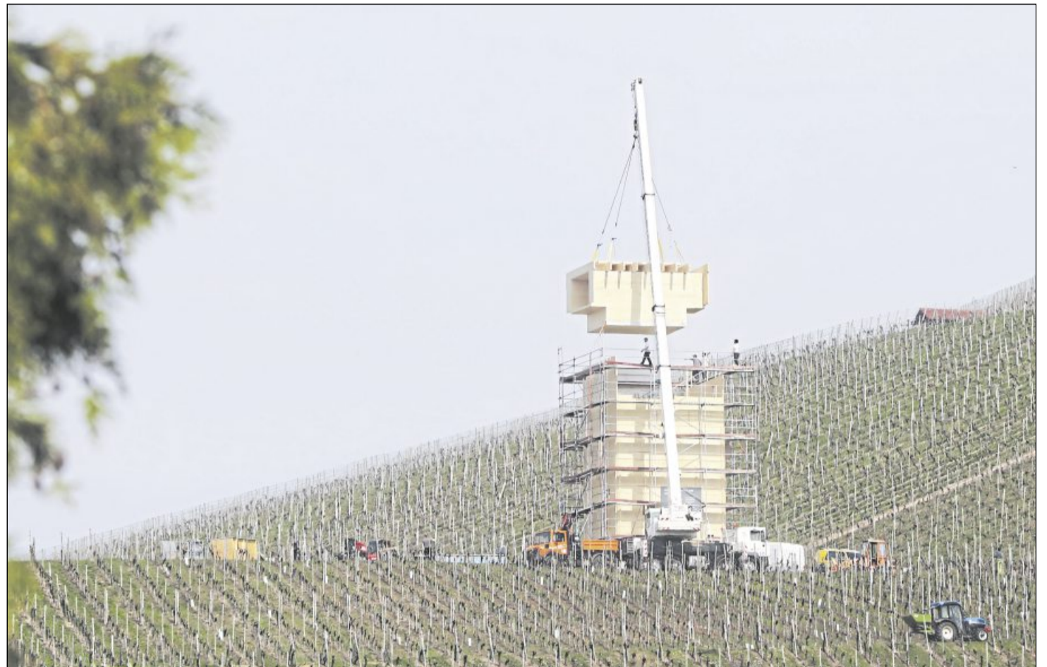
Bereits Anfang April hat der Turm des Architekten Stephan Rauch in den Weinbergen seine volle Größe – 13 Meter – erreicht. Hier wird der 9,5 Tonnen schwere Aussichtsraum passgenau eingesetzt. Foto: Habermann
